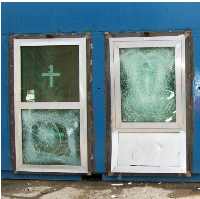
Prüfelemente nach dem erfolgreichen Test, keine Splitterabgang, GSA Level 2. Test elements after the successful blast test, GSA level 2.
